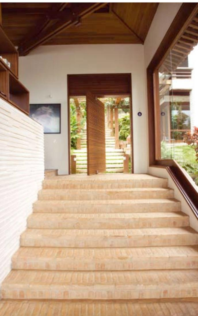
**COM ACESSO AO MEZANINO** e à área externa, a escada é revestida com tijolos de barro - piso de fácil limpeza e de uma rusticidade elegante. A porta pivotante tem 2,40 m de base x 3,50 m de altura, também de madeira cumaru com ferragens de inox escovado.
